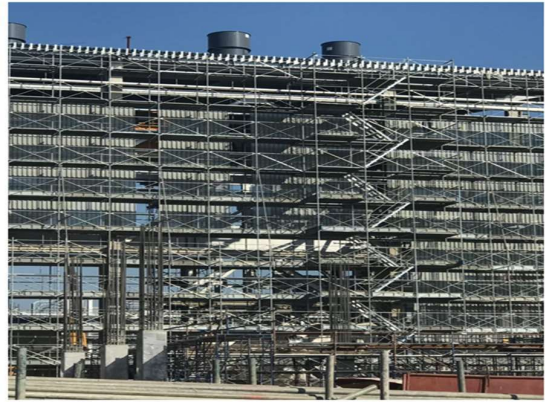
โครงการก่อสร้างงานระบบประกอบอาคาร TUM 3.2
