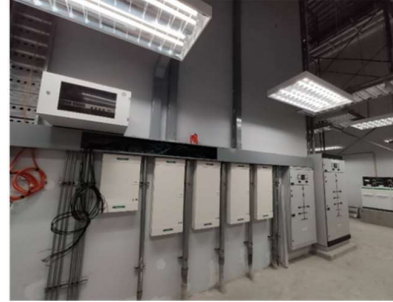
งานติดตั้งตู้ไฟฟ้าคอนโทรล
