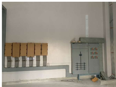
งานติดตั้งตู้ควบคุมระบบบิ๊มน้ำ
