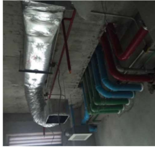
งานติดตั้งท่อและช่องส่งลมเย็น (Piping and Ducting)
