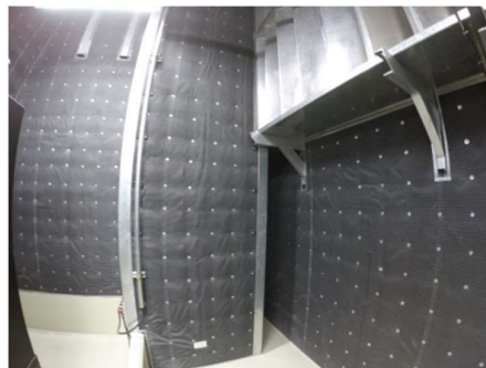
งานติดตั้งระบบห้องกันเสียง
